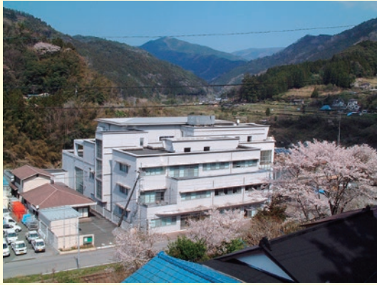
大豊町あったかふれあいセンターの拠点の概観 (1階の一部分で実施)
