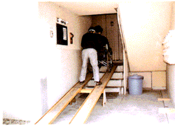
5 玄関にはスロープが取り付けられ、外出が可能になった
