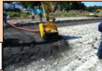
固化剤を用いた削り取り
