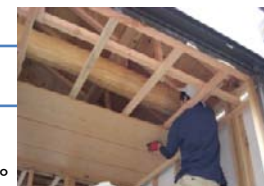
<天井リフォーム作業>
