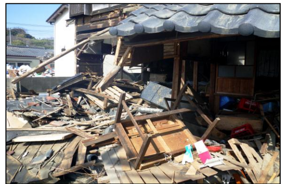
津波で倒壊した住宅（北茨城市）
