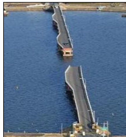
橋桁の中央部が崩落した鹿行大橋 (行方市-鉾田市)
