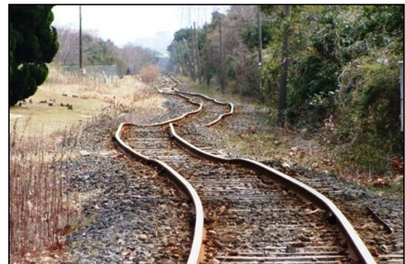
地震で線路が歪んだ大洗鹿島線（鉾田市）
