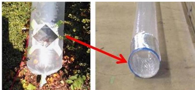
図-10 ビニールダクトの先端部分を環状の支え（アルミ製ダクト）を重ねて使用した例
