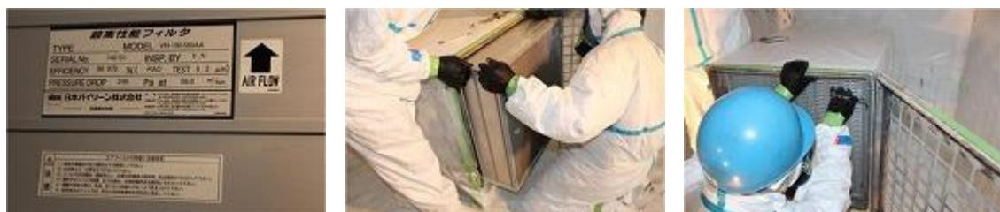
②HEPA フィルタの装着後装置を稼働させ、スモークテスターを用いて側面からの吸い込みがないかを確認する。必要に応じて、HEPA フィルタ面をシート等で塞いだうえ、スモークテスターでの吸い込みを確認する。
