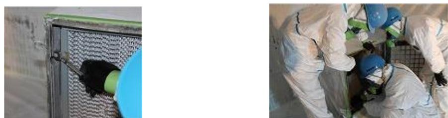
⑥HEPA フィルタを交換する場合は、取り外して粉じん飛散抑制剤・粉じん飛散防止処理剤を散布した後、プラスチック袋等により二重梱包のうえ、特管「廃石綿等」として廃棄物処分。
