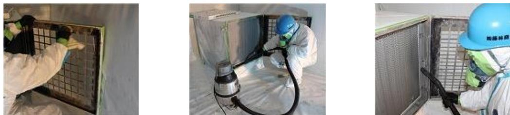
⑤HEPA フィルタの交換を行わない場合は、HEPA フィルタの傷や留め付けの緩み等を点検する。
