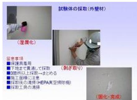
図－4 サンプリング例（外壁材）
