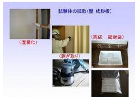
図－5 サンプリング例（成形板）
