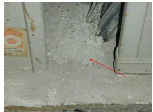
写真II-12 電気配線部分隙間閉鎖
