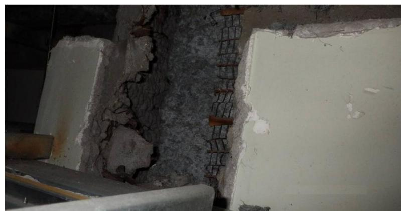
**写真 II-13** 壁の中に青石綿が吹かれ拉斯網の上モルタル+プラスター塗り仕上げ
