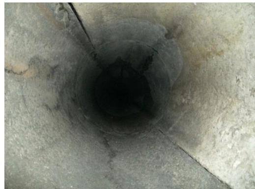
写真II-10 煙突用断熱材ハイスタック (2分割)
