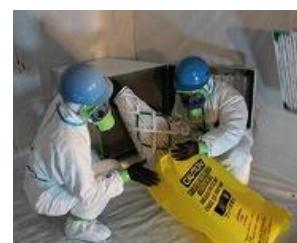
④HEPA フィルタの周辺部を HEPA フィルタ付高性能真空掃除機または濡れウエス等で十分に清掃する。
