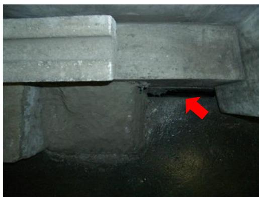
写真II-16 スラブ層間塞ぎ充填材なし
