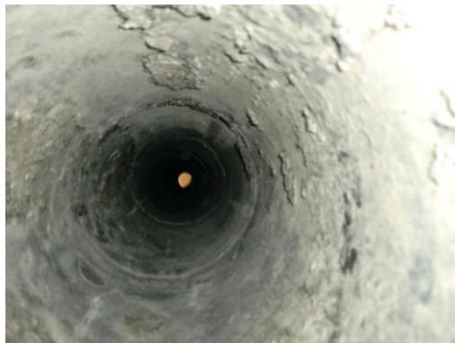
写真II-11 ライナー付きカボスマック煙突断熱材
