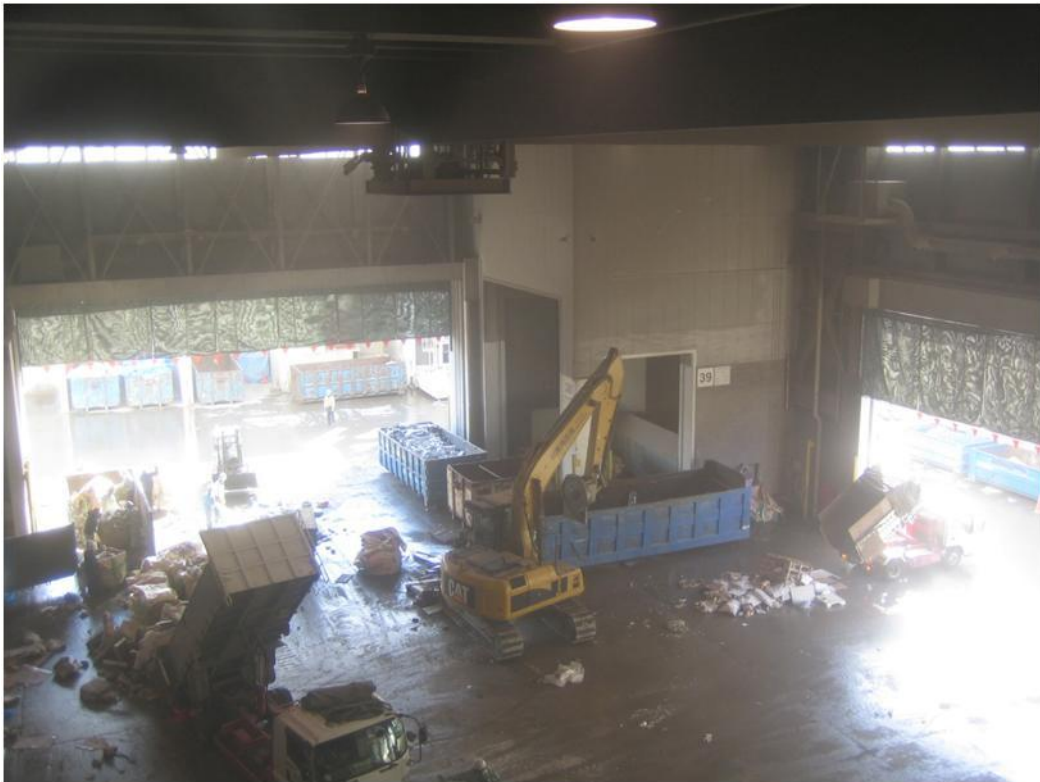
ダンピングヤード全体図（上から撮影） 写真の左下及び右下で、廃棄物の荷降ろし中
