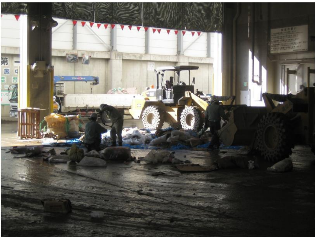
ダンピングヤード 降ろされた廃棄物を重機と作業員の協働による仕分け
