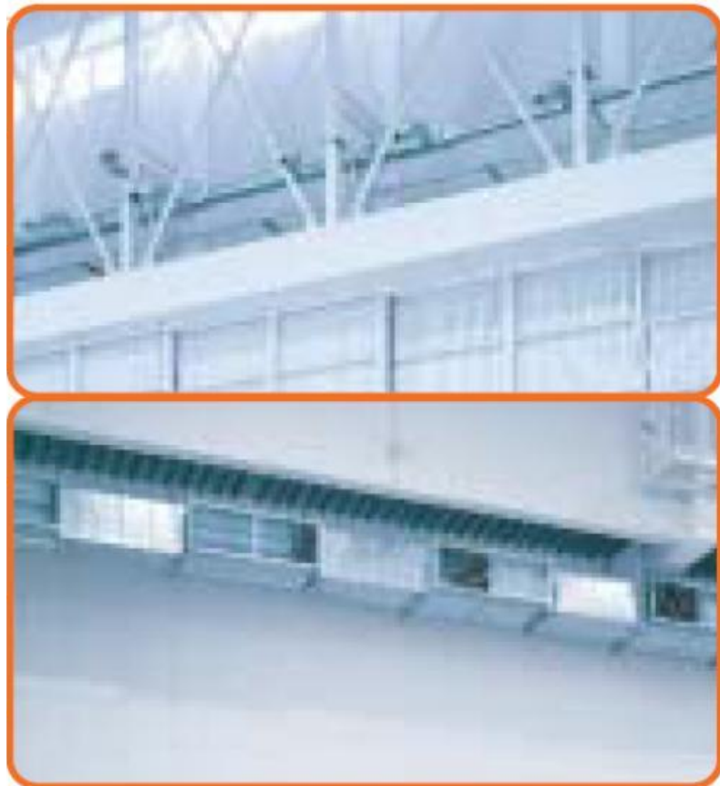
ダンピングヤード集じん吸引装置 上：送風口、下：吸引口
