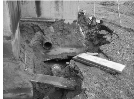
写真-2 神宿浄水場混和池
