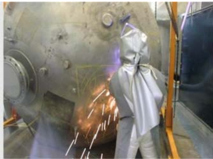
プラズマ切断機を用いた切断
