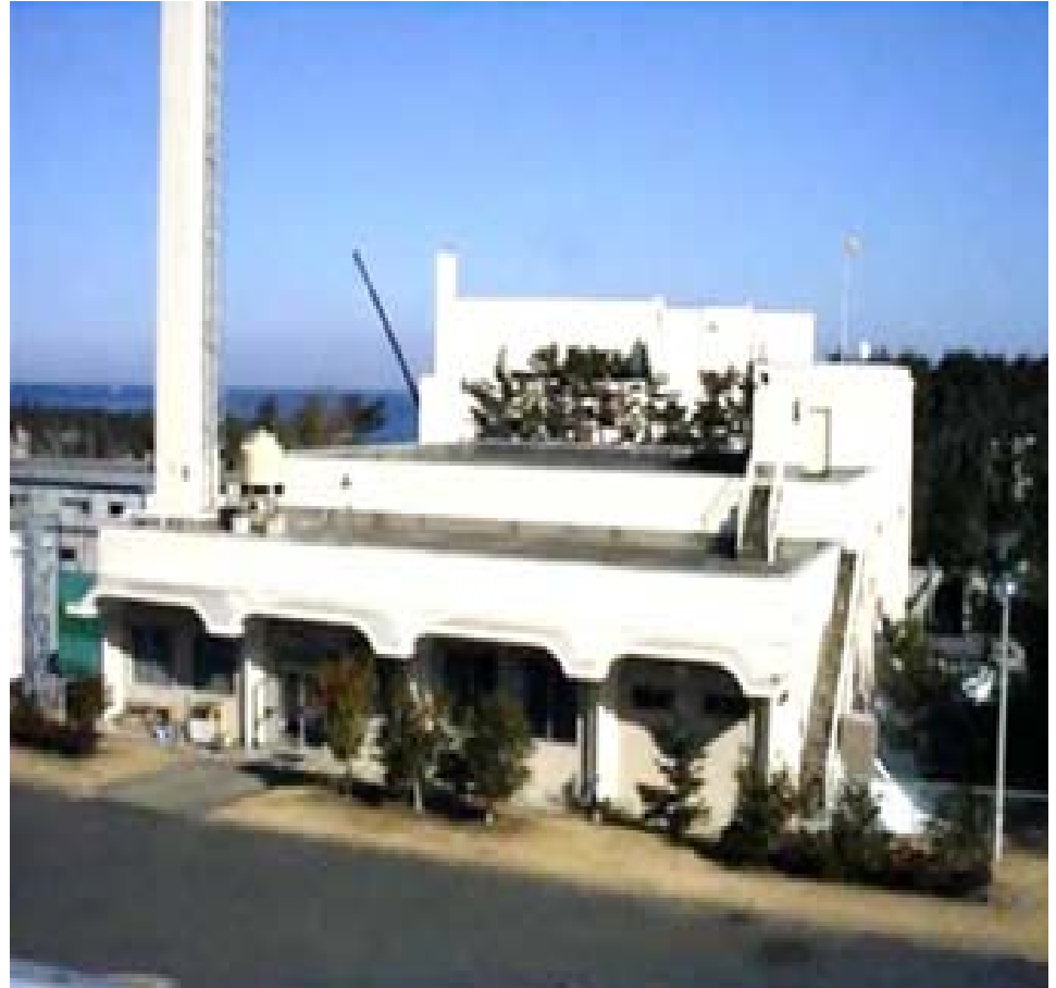
【第1廃棄物処理棟】
