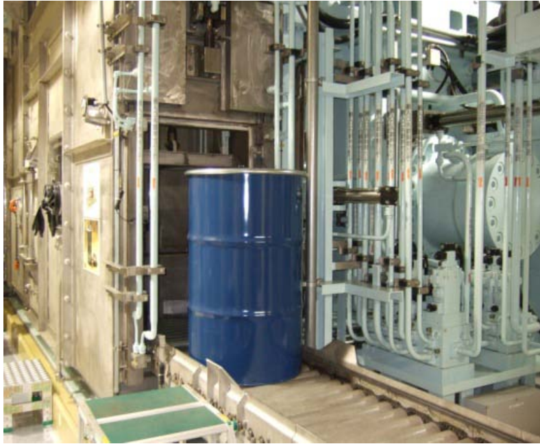
高圧圧縮装置ドラム缶搬入部付近
