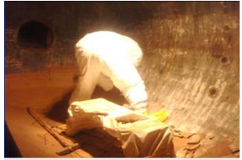
タンク内面のライニングの剥離
