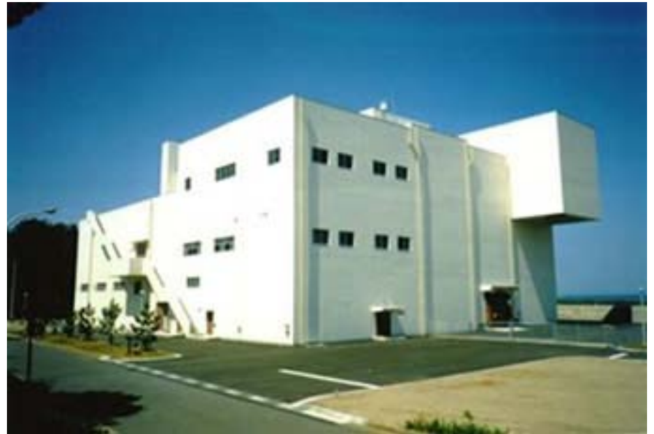
【解体分別保管棟】
