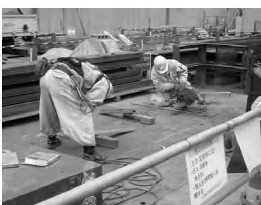
屋外における、鉄製アングルの被覆アーク溶接作業を対象に、延べ2名の作業者について、個人サンプラーによる粉じん濃度の測定、粉じん濃度の経時的变化及び粉じんの10分間移動平均濃度の推移を測定した。
