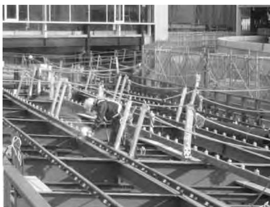
屋外における、屋根取付部材の被覆アーク溶接作業を対象に、延べ3名の作業者について、個人サンプラーによる粉じんの濃度の測定、粉じん濃度の経時的変化及び粉じんの10分間移動平均濃度を測定した。
