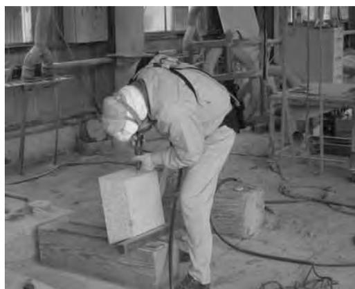
屋内における、手持ちグラインダー、ビシャン工具による石材の研削作業を対象に、延べ6名の作業者について、個人サンプラーによる粉じん濃度の測定、粉じん濃度の経時的変化及び粉じんの10分間移動平均濃度を測定した。
