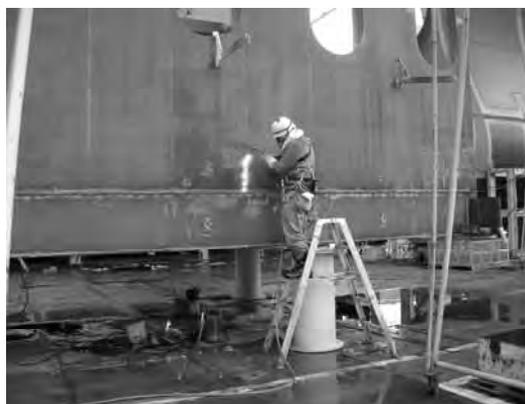
屋外における、鋼製吊金具等のガス溶断作業を対象に、延べ5名の作業者について、個人サンプラーによる粉じん濃度の測定、粉じん濃度の経時的変化及び粉じんの10分間移動平均濃度の推移を測定した。
