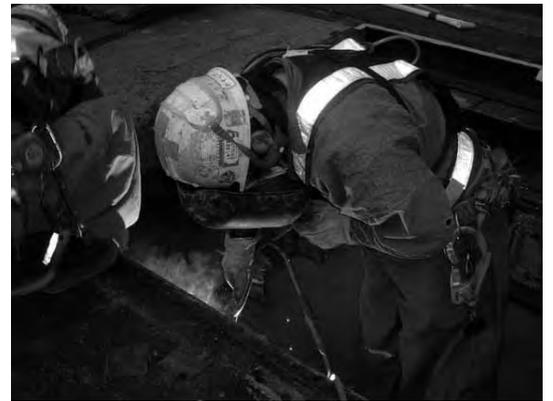
屋外における、覆工板設置及び補修のための被覆アーク溶接作業を対象に、延べ4名の作業者について、個人サンプラーによる粉じん濃度の測定、粉じん濃度の経時的变化及び粉じんの10分間移動平均濃度を測定した。
