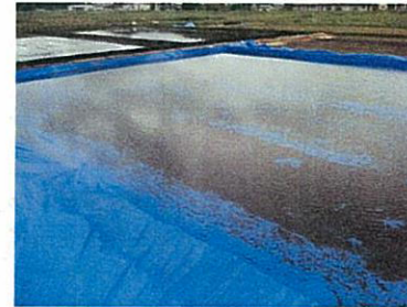
写真3：沈砂地における固液分離
