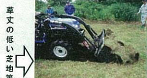
フロントローダを用い、すくい上げによる搬出する。
