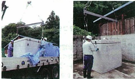
写真1：コンクリート製容器の設置
