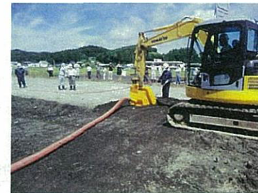
写真3：表層土の削り取り
