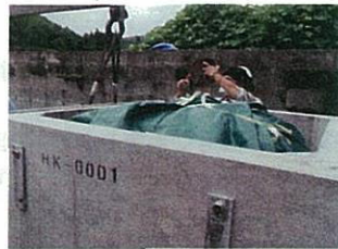
写真2：フレコンバッグ挿入後の状況
