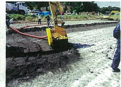
写真4：改良したバケット部
