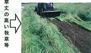
フロントローダを用い、引き剥ぎによる搬出する。
