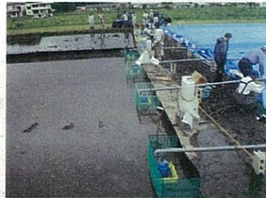
写真2：沈砂地への濁水の排出
