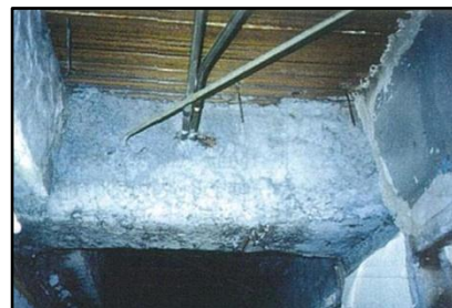
石綿による鉄骨の耐火被覆※12
