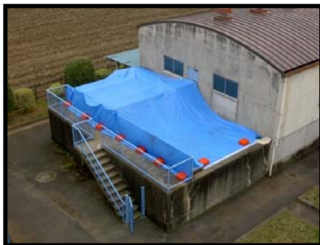
【筑西市 成田浄水場 着水井 覆蓋】
