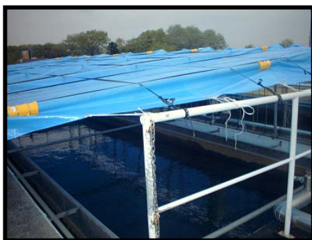
【守谷市 守谷浄水場 沈殿池 覆蓋】
