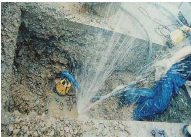
水道管からの漏水の状況
