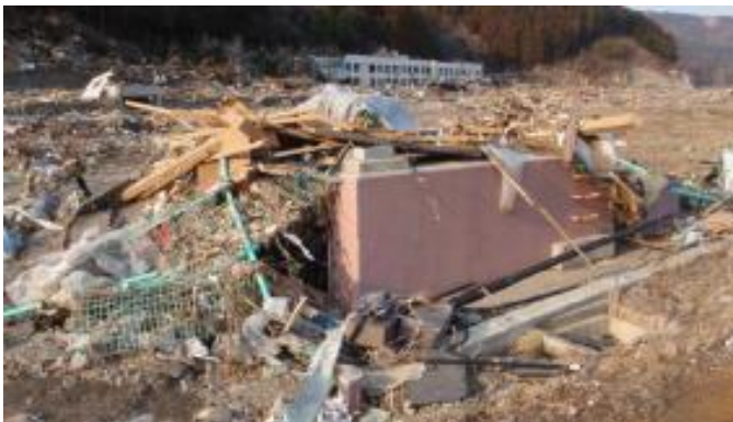
津波で流失した三本松取水場（雄勝地区）
