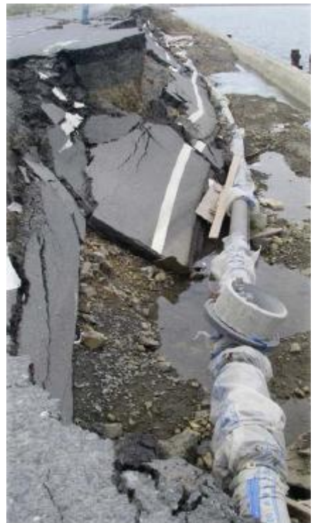
水道管の被害の状況
