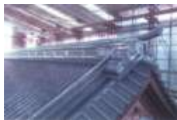
金沢城復元工事(河北門屋根工事)
