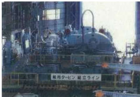
船用蒸気タービン主機・減速装置の組立ライン
