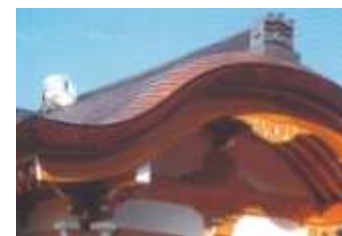
専念寺唐破風銅板工事
