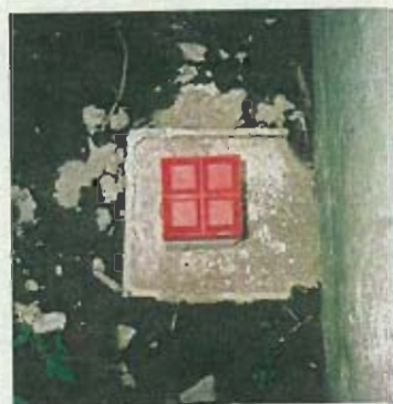
コンクリート杭
