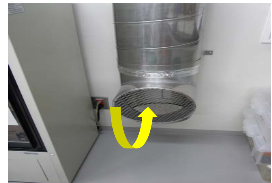
クリーンルーム内排気口
