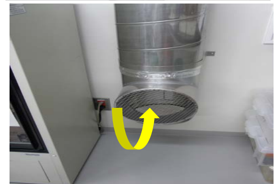
クリーンルーム内排気口
