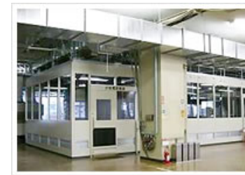
(STEP1 JT分煙試験室)
