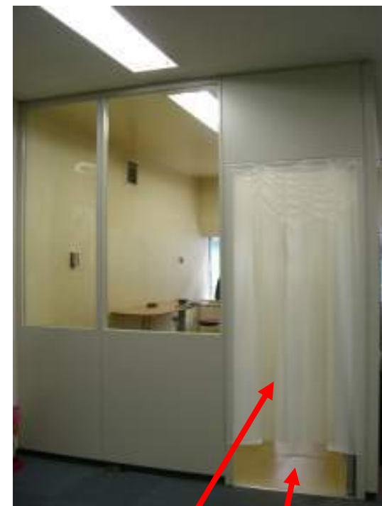
ビニールカーテン
