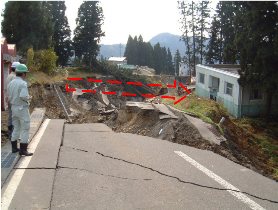
新潟県中越地震(H16.10.23)による地滑りで数10m移動した浄水場(小千谷市塩殿簡易水道)
