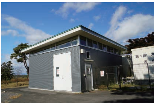
制御盤・濾過室
