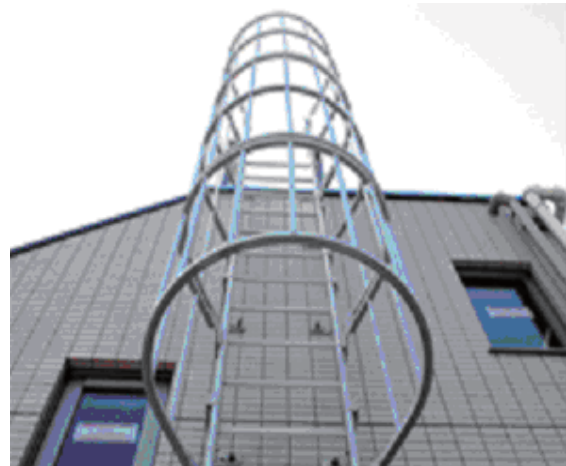
写真8 固定タラップの例
