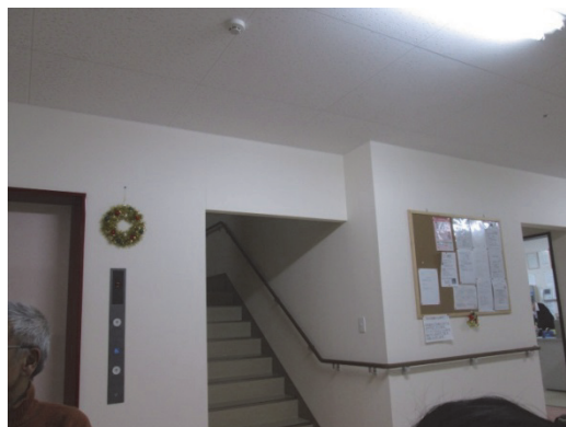
写真19 階段室の下がり壁
