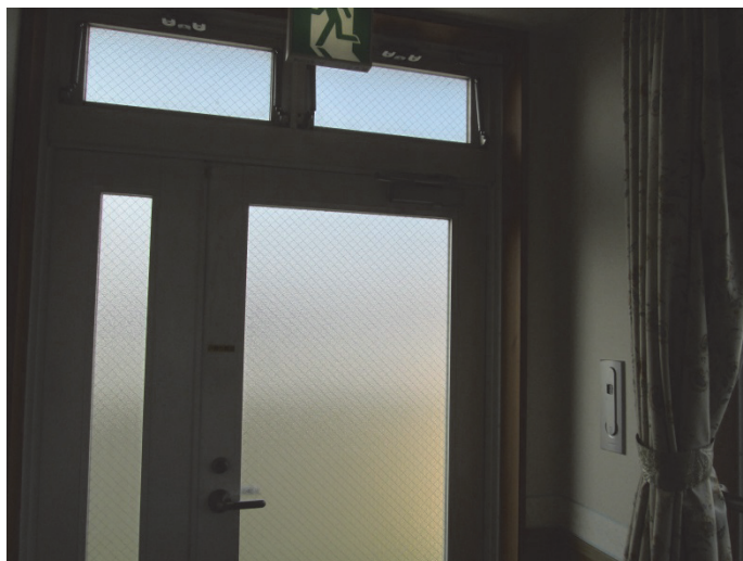
写真1 排煙窓と操作スイッチ
