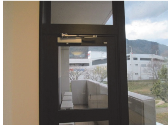
写真 16 廊下の端のバルコニー
