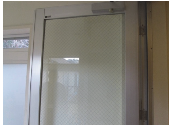
写真6 ユニット間の通路にある防火設備
