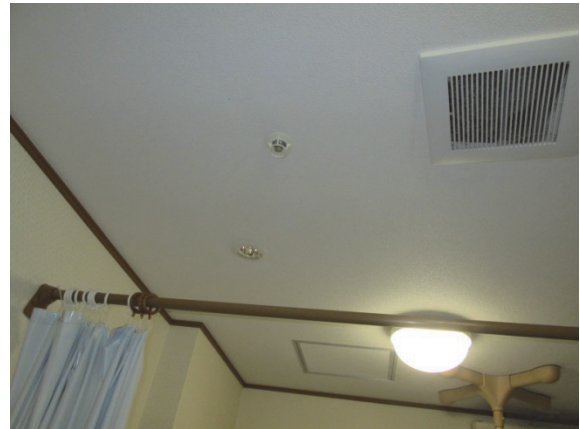
写真7 カーテンが散水障害となる恐れがある
