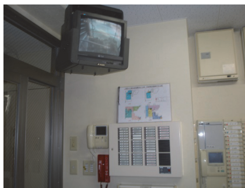
写真 3 監視カメラの映像(死角になる場所は、監視カメラでモニター)
