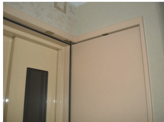
写真 2 エレベータシャフトの遮煙性確保
