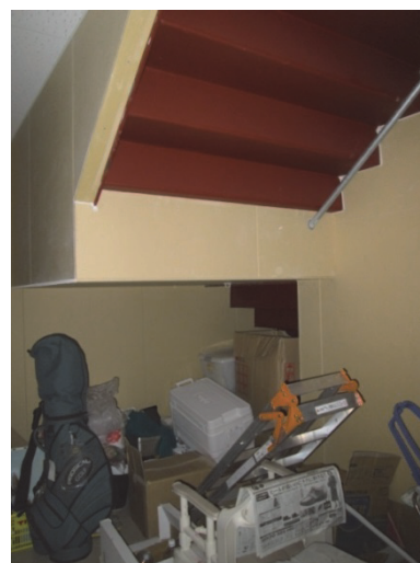
写真20 階段下の状況
