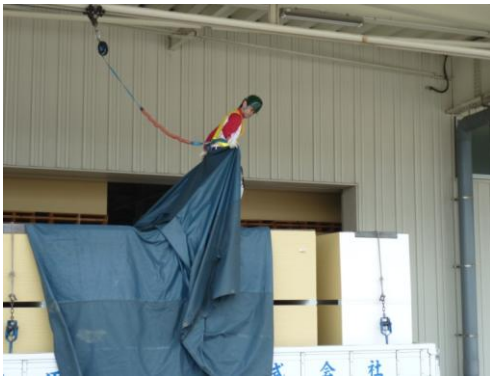
シート掛け作業（1）
