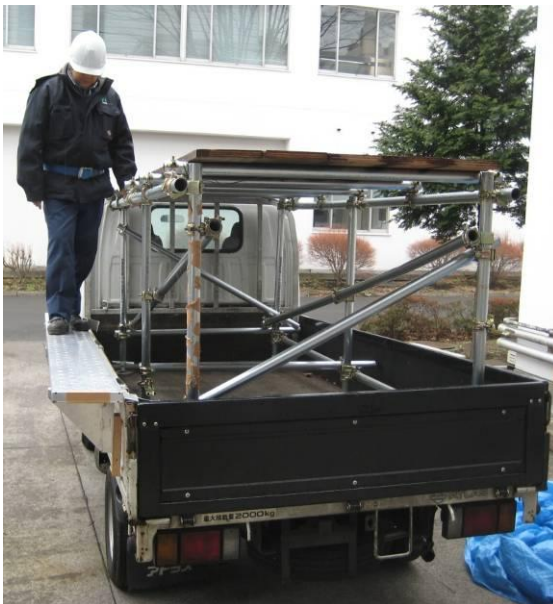
簡易作業床をあおりに取り付け 歩行している様子
