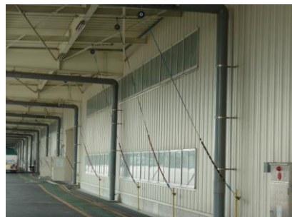
安全带取り付け状況
