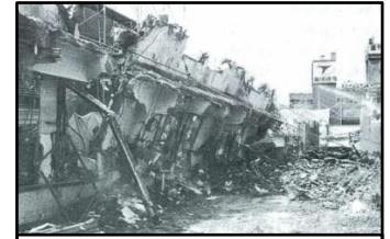
コンクリート壁の引倒し作業 ※2
