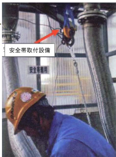
図 4-30 タンクローリー上部の建屋内に設置された安全帯取付設備
