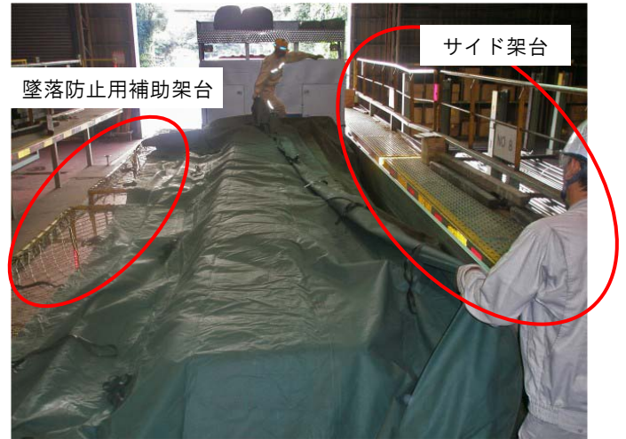
図 4-22 シート掛け作業風景
