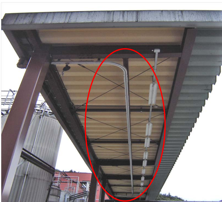
図 4-32 建屋天井に設置したレール。運転手が安全帯を着けても容易に移動できるようにしている。
