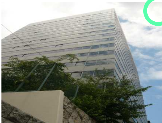
近畿厚生局(大阪合同庁舎第4号館)
