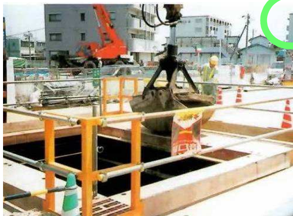
建設現場の墜落防止措置
