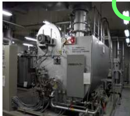
工場などで稼働しているボイラー
