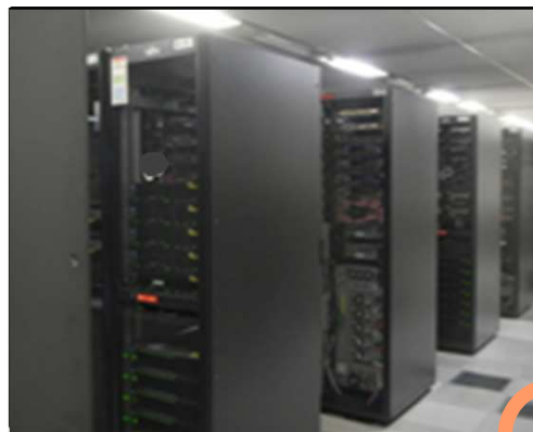
サーバールーム
