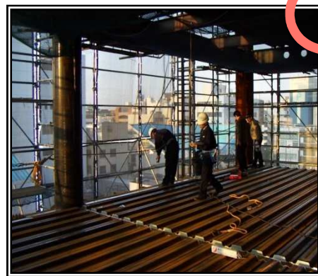
労働災害発生現場での災害調査
