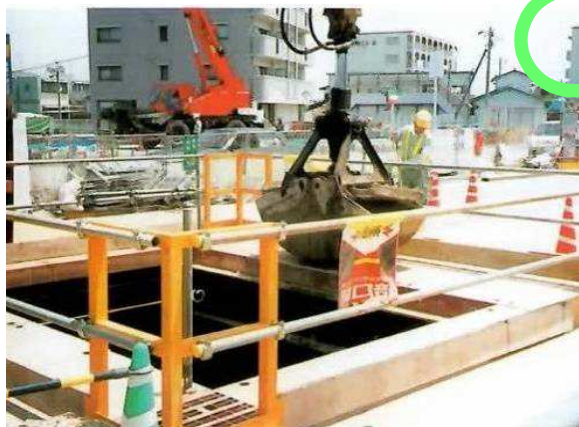
建設現場の墜落防止措置
