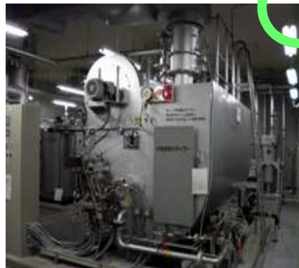
工場などで稼働しているボイラー
