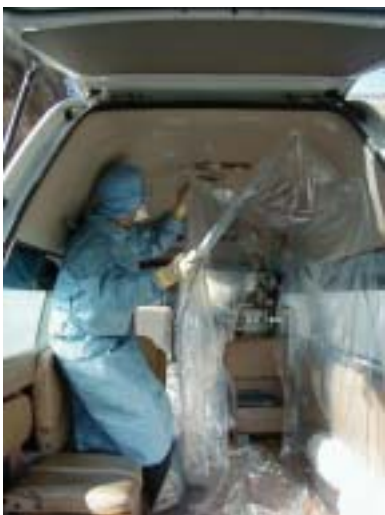
患者搬出後の撤去作業
