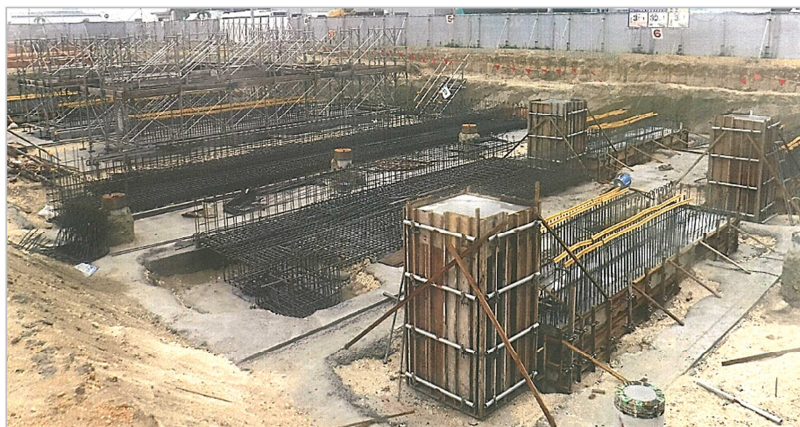
〔作業現場の様子：手前の木枠が型枠（E社提供）〕
