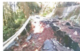
▲ 地震による道路や水道管破損の様子
