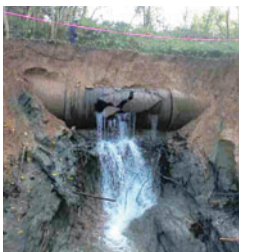
▲ 水道管の破損による土砂流出
