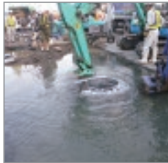
[熊本地震では水道管が破損し、街に水があふれ出しました]
