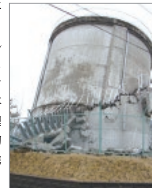
[東日本大震災により倒壊した水道施設]
