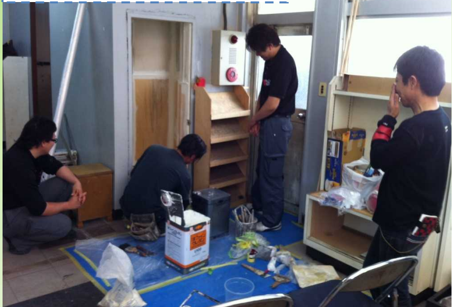
リフォーム業者（塗装作業の現場）
