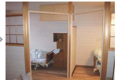
明かり取りの障子窓をつける窓枠の設置(工事中)
