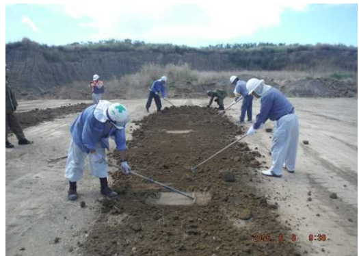
掘削した土砂を仮置き場で確認
