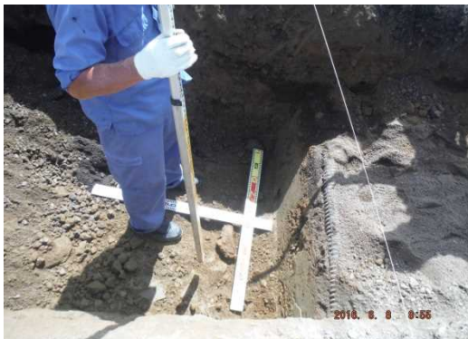
反応箇所の掘削
