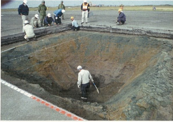
滑走路下の掘削
