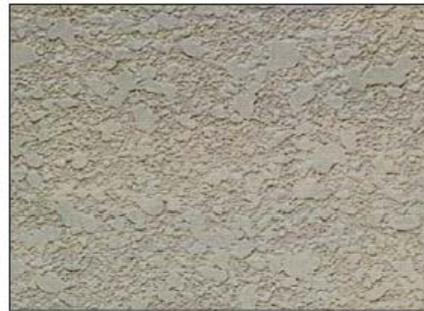
\* 石綿含有の可能性があるのは、主材、下地調整塗材である。
