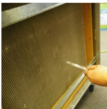
写真Ⅷ-1 HEPA フィルタ面
