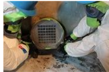
写真Ⅶ-4 集じん・排気装置の排気口をプラスチックシート等で封鎖
