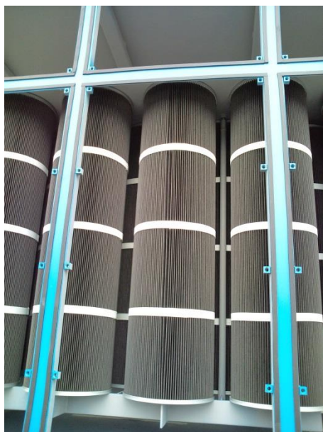
写真X-2 プリーツ成形フィルタの例
