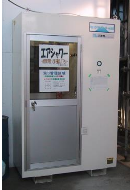
写真X-4 エアシャワールーム（2重扉）の例
