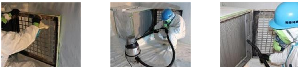
写真Ⅶ-8 HEPAフィルタ等の清掃
