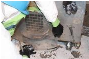
写真Ⅶ-4 集じん・排気装置の排気口をプラスチックシート等で封鎖
