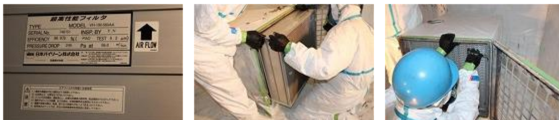
写真Ⅶ-11 フィルタの取り付け
