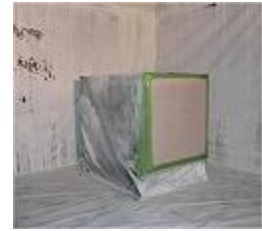
写真Ⅶ-3 集じん・排気装置による除じん
