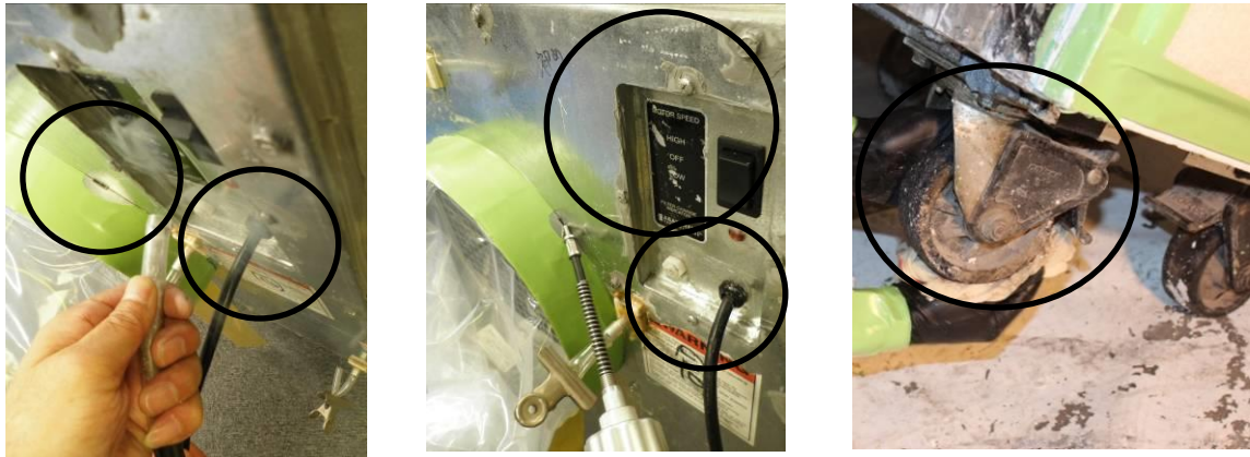
写真Ⅷ－3 漏れの発生しやすい箇所の例
