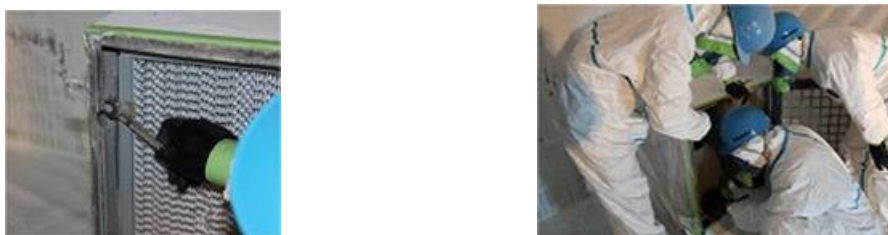
写真Ⅶ-9 HEPAフィルタの留め付けの緩み点検
