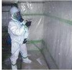
写真Ⅶ-2 養生シートへの散布
