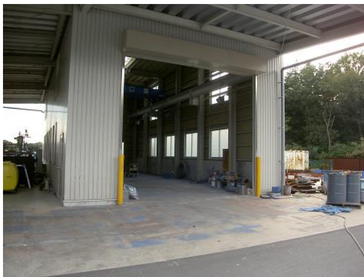
写真X-6 除染ブースの例
