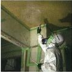
写真Ⅶ-1 除去面への散布
