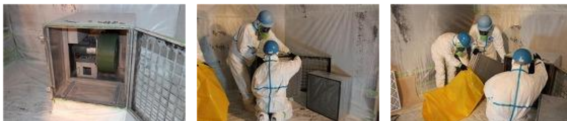
写真Ⅶ-10 HEPAフィルタの交換
