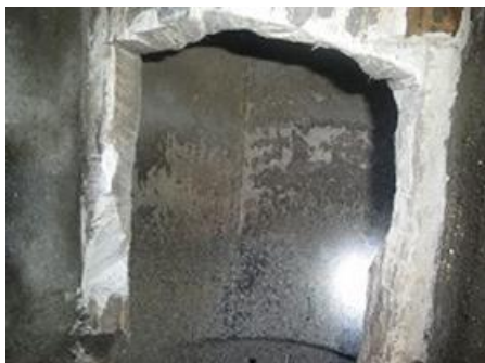
写真Ⅱ-10 ハイスタック煙突断熱材
