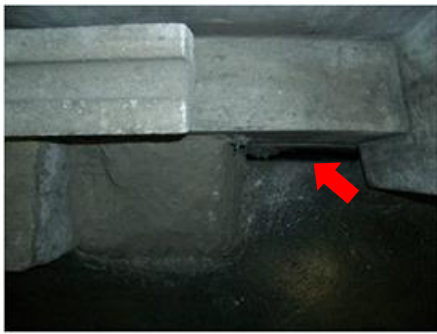
写真Ⅱ-16 スラブ層間塞ぎ充填材なし
