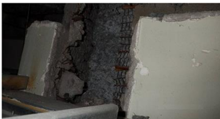
写真Ⅱ-14 壁の中に青石綿が吹かれラス網の上モルタル+プラスター塗り仕上げ
