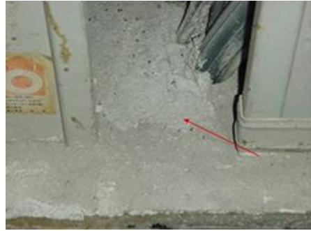
写真Ⅱ-13 電気配線部分隙間閉鎖
