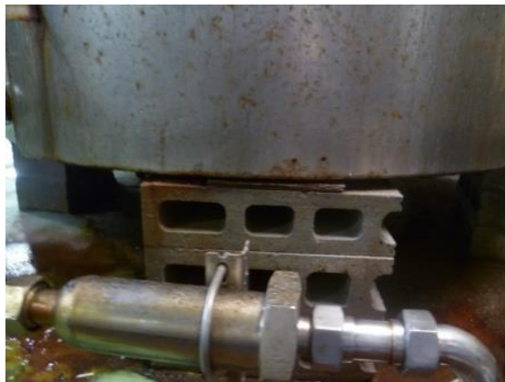
空洞部分に害虫発生の可能性
