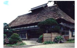
伝統木造住宅
