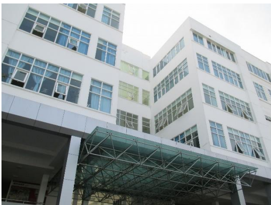
□ベンチエ省病院 正面外観 二次病院、ホーチミン市内から2時間30分。登録病床1100床。同病院の麻酔科医はセミナーに参加された。
