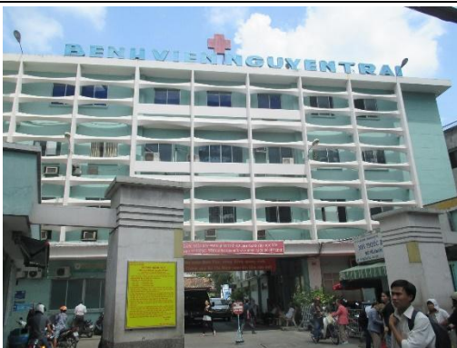
□グエンチャイ病院 外観 ホーチミン保健局管轄。二次病院。手術室・ICUには患者モニタ（日本光電）も多数配備。
