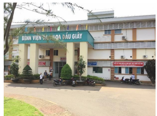
□ソンガイ郡病院 外観 二次病院、登録病床155床。ドンナイ省内の郡病院。全身麻酔は0件、手術室は工事中であった。
