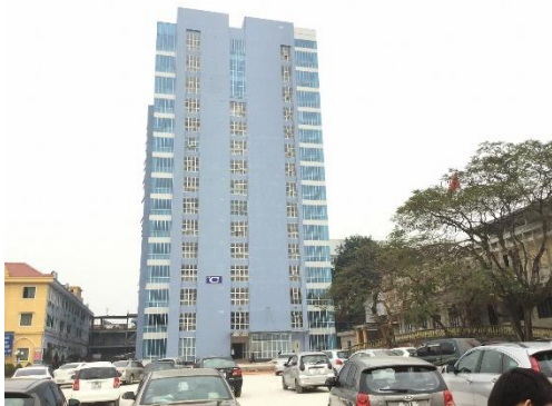
□タイグエン国立中央病院 外観 三次病院。登録病床1000床。写真のビルは、一部建設途中の拡張した病棟。
