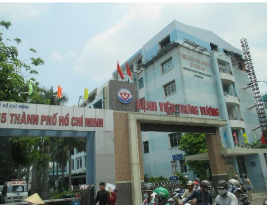
□トゥンブオン病院 外観 ホーチミン保健局管轄。二次病院、登録病床700床。敷地内には、池や寺院も整備されていた。
