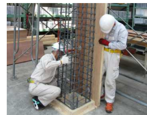
建設施工技術科の実習風景 （鉄筋・型枠施工実習）
