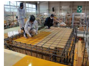
スラブ配筋実習
