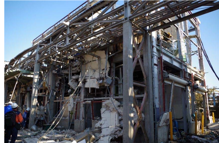
災害現場での調査の様子
