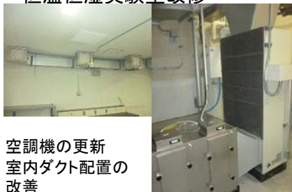
恒温恒湿実験室改修
