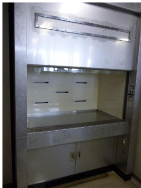
実験室フー ド改修
