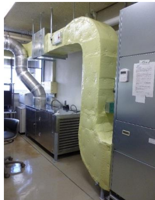
機器分析室 改修
