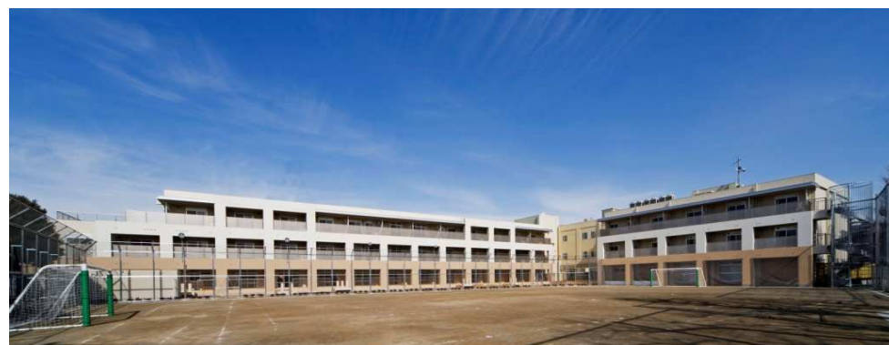
建物外観(改修後)
