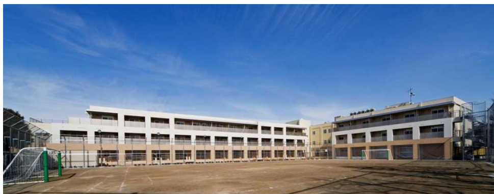
建物外観(改修後)
